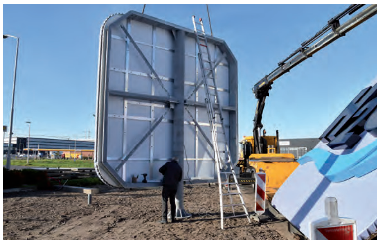
▲ Smart-Sign maakte een slimme constructie voor de doeklichtbakken.
