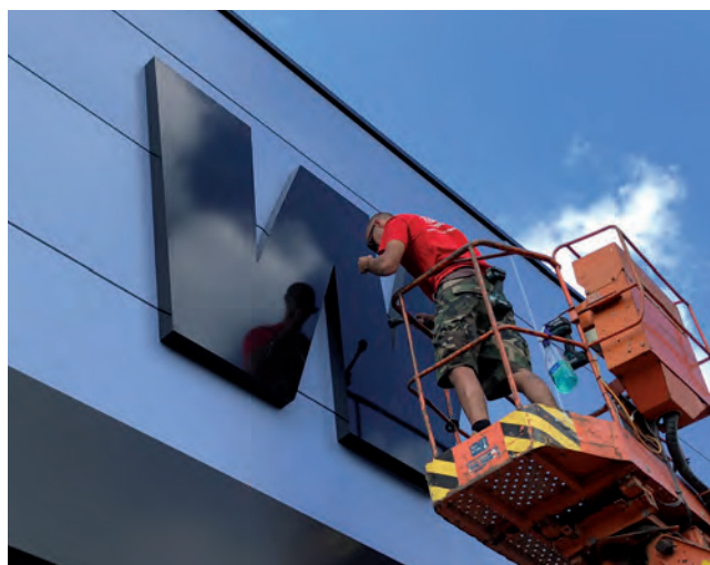
▲ Er waren hoogwerkers op rupsbanden nodig voor het aanbrengen van de gevelreclame.
