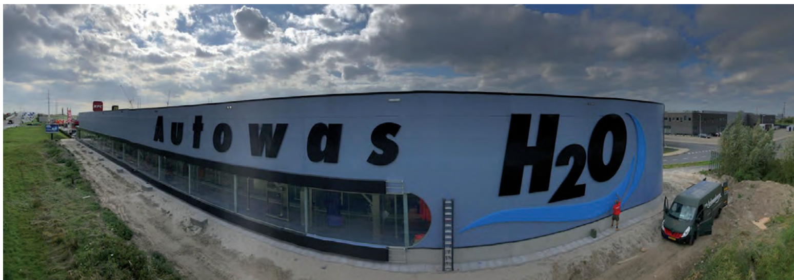
▲ Op de gevel zijn onverlichte aluminium doosletters geplaatst, van maximaal 4,5 meter hoogte. De blauwe golven zijn 12,4 meter lang.
